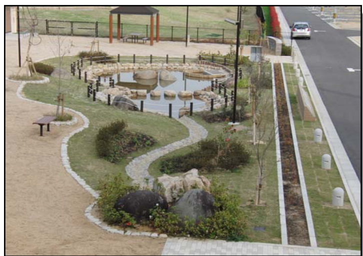
ビオトープ・池・せせらぎ完成
